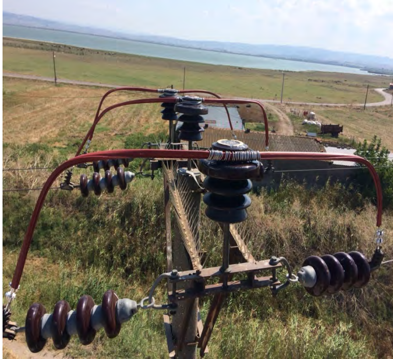
Şekil 4. UEDAS Bandırma Bölgesi Kuşcenneti Sıkı Bağ, Giydirme ve Kuşkonmaz Çalışması
