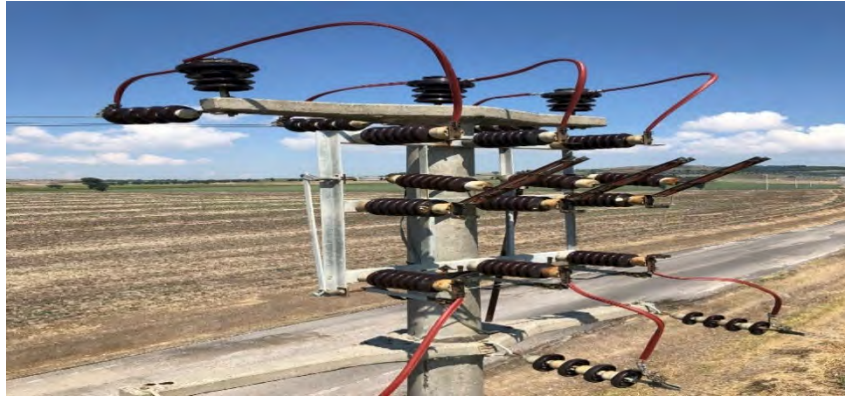
Şekil 3. UEDAS Bandırma Bölgesi Doğruca Hattında Bakımı Yapılan HSTA ve Atlamalar
